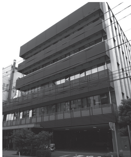
府中多摩保健所がある 東京都府中合同庁舎
